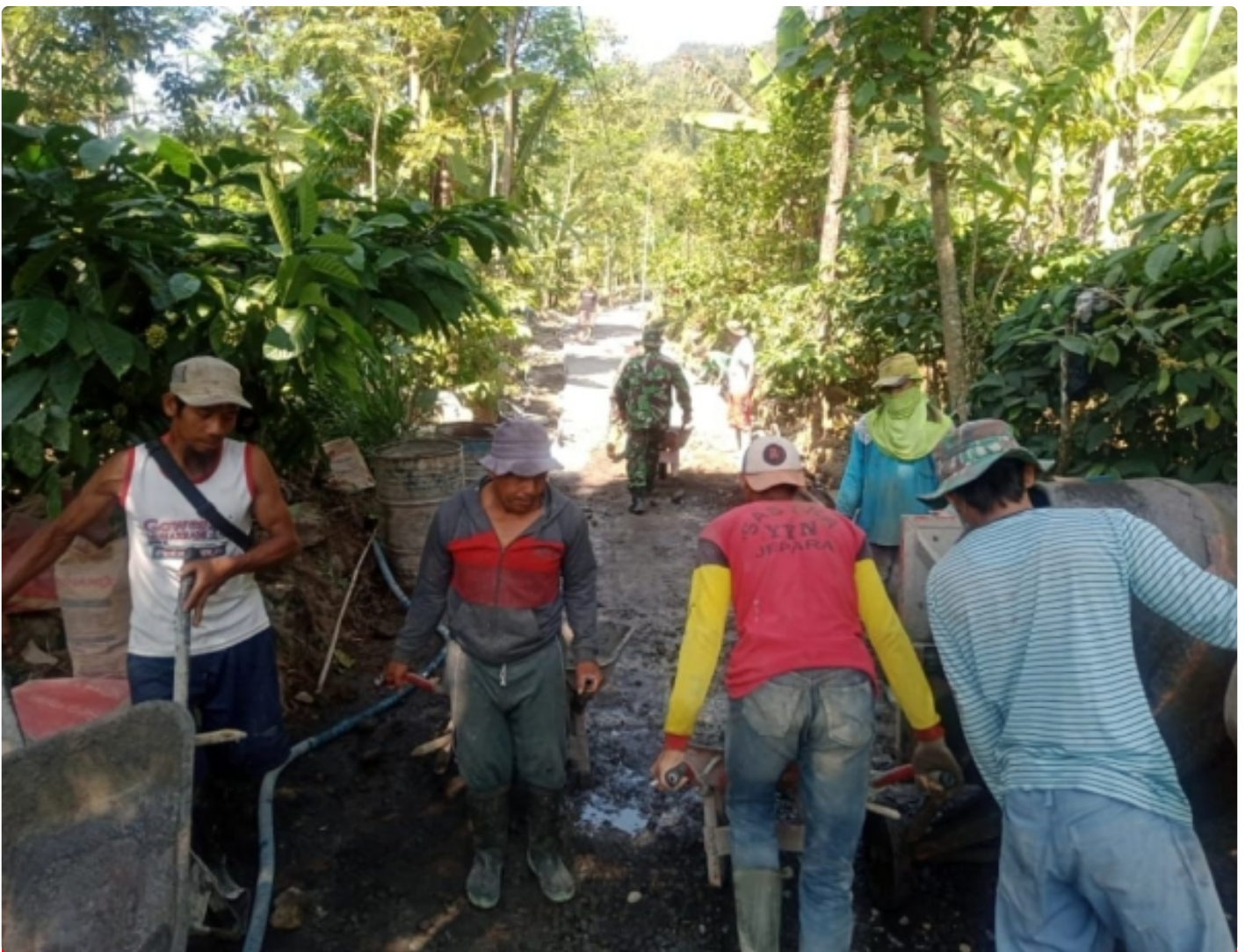
Warga Desa Tempur bergotong-royong pengecoran jalan menuju candi angin
